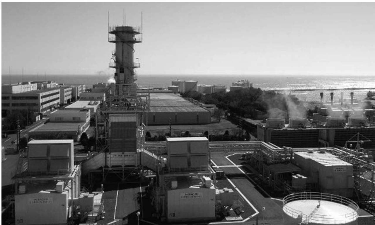
図1 完成した日立臨海発電所第2号機の全景
