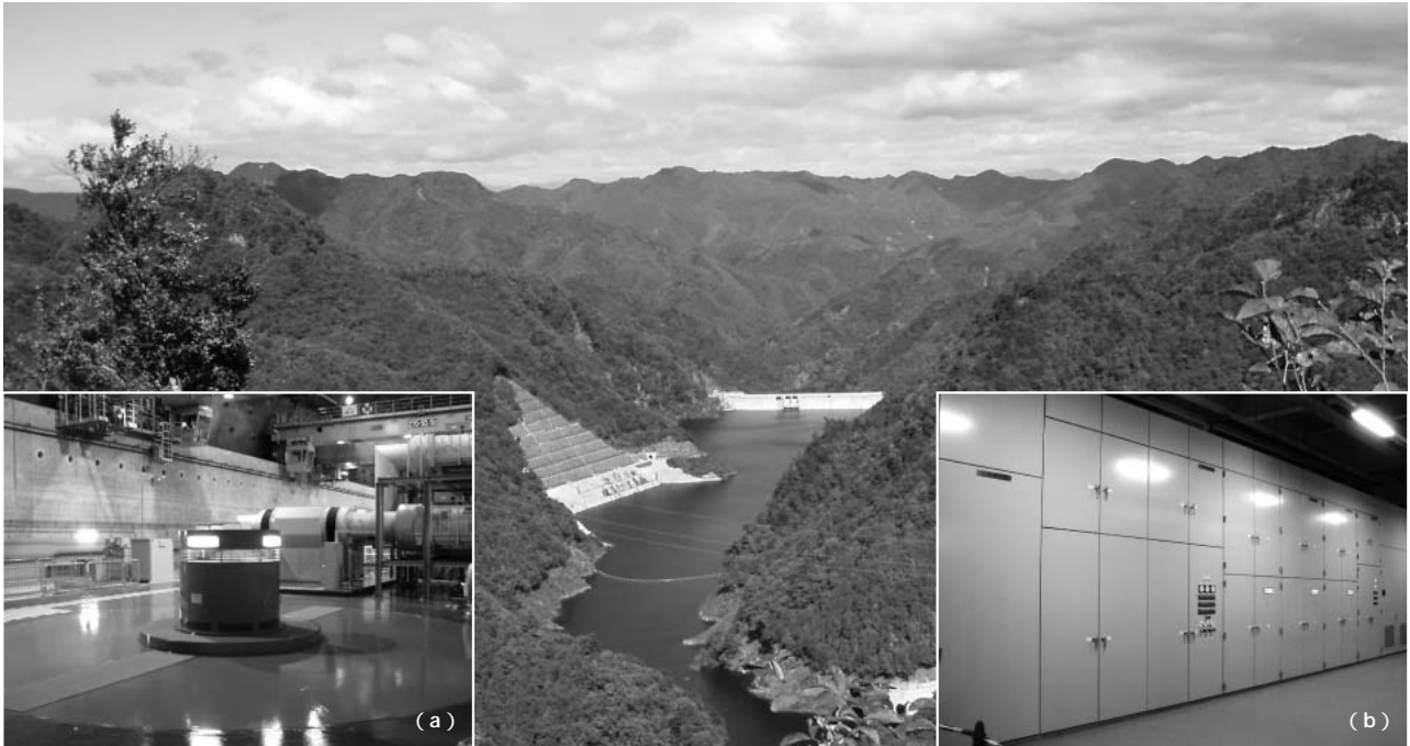
図1 奥神流湖の景観(群馬県上野村)と発電所内の機器
