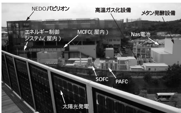
注:略語説明 NEDO(独立行政法人新エネルギー・産業技術総合開発機構) MCFC( Molten Carbonate Fuel Cell ), SOFC( Solid Oxide Fuel Cell ) PAFC( Phosphoric Acid Fuel Cell )
