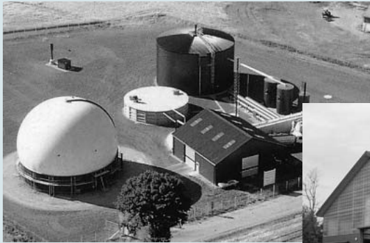
バイオガスシステム
