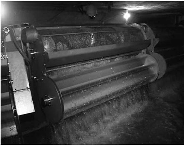
図7 ストームスクリーンの運転状況
