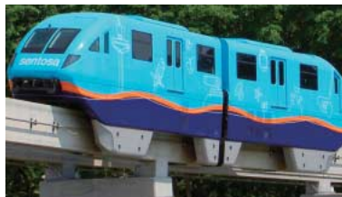
図10 セントーサエクスプレスモノレール シンガポールのセントーサ島へのメインアクセスとして2007年1月以来、順調に稼働している。
