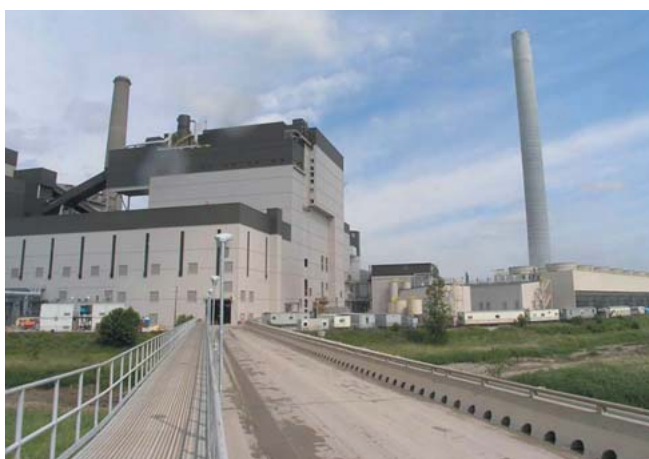
5 米国MidAmerican Energy Companyの蒸気タービン・ボイラ建屋
