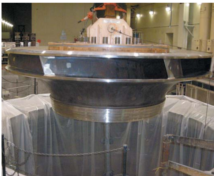
9 米国ギルボア揚水発電所第2号機の新ランナ吊り込み(左)と新製入口弁吊り込み(右)
