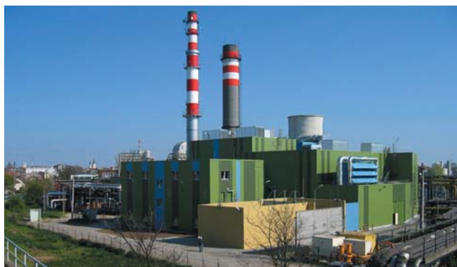
6 E.ONハンガリー株式会社の発電設備建屋全景
