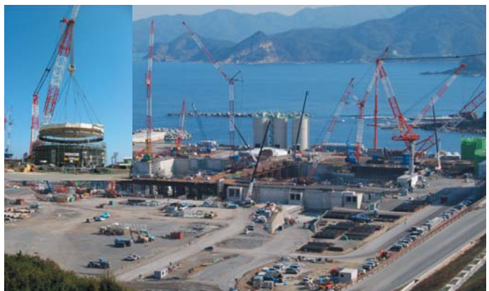
2 建設中の島根原子力発電所3号機 (世界最大級の大型クローラークレーンによる大物機器吊り込み状況)
