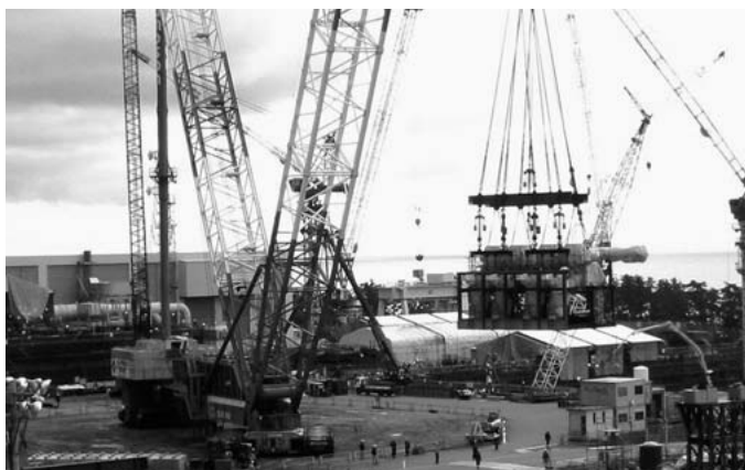
大型モジュール工法
