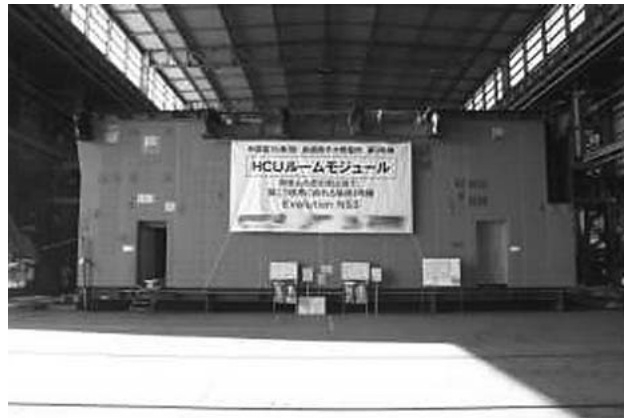
図8 HCUモジュール製作状況(HCU室モジュール全景) HCU室モジュールの全景を示す。出荷前の最終仕上げ段階に入った(2008年1月撮影)。
