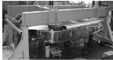
図8 工場内での部分組立状況
