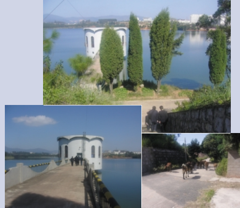
化学プラント、排ガスファン/工水取水ポンプ場
