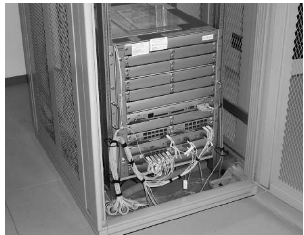
図3 キャンパスネットワークのコアスイッチ 日立ギガビットスイッチ「GS4000-320E」を示す。
