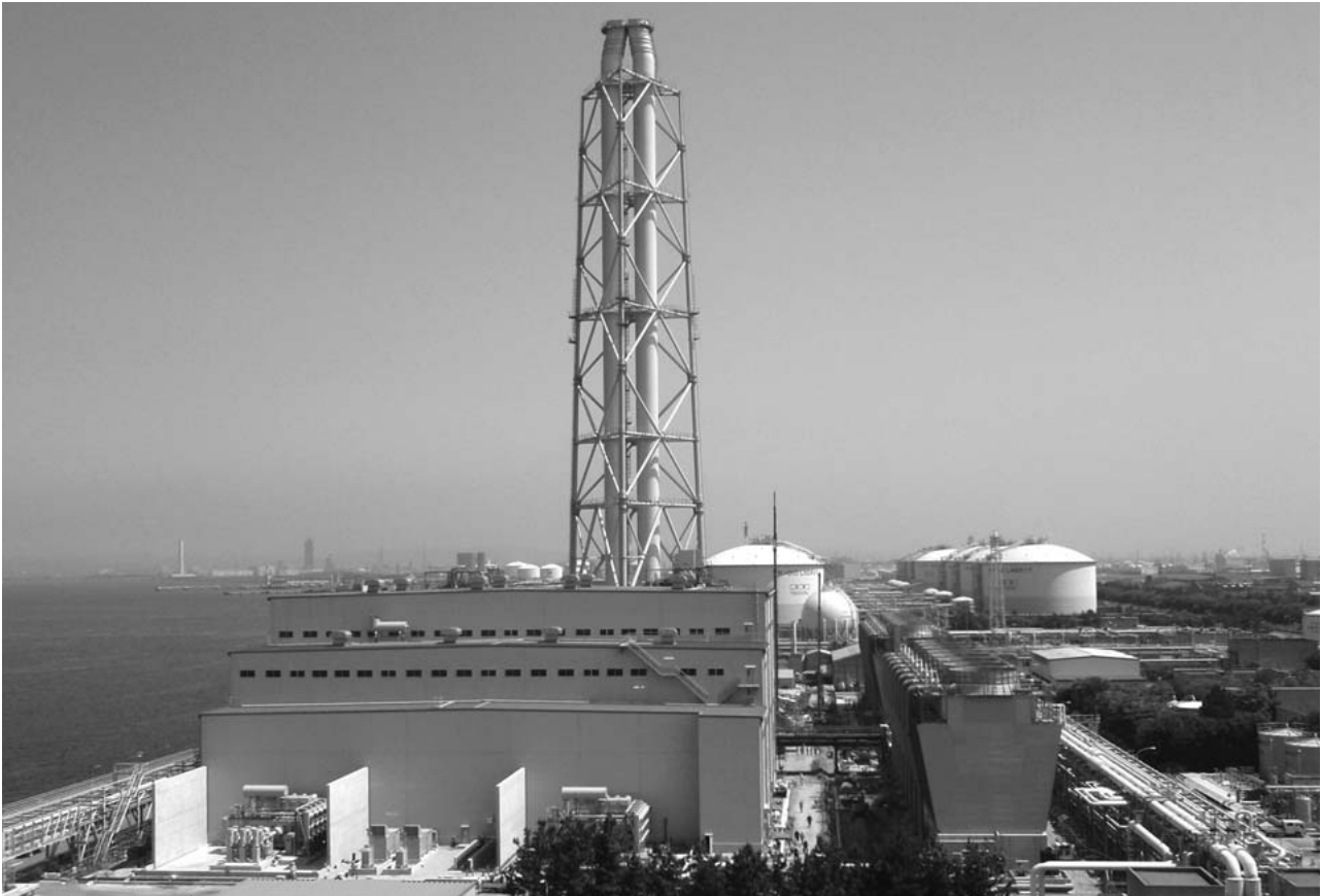
図1 大阪ガス株式会社泉北製造所第二工場内の発電所
