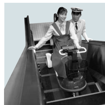
[8] 3枚方式車いす用ステップ付き エスカレーター
