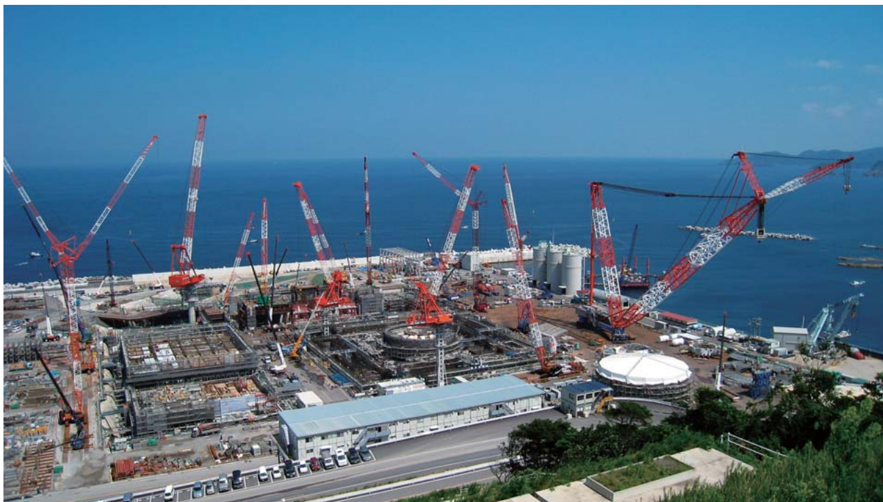
図1 建設中の中国電力株式会社島根原子力発電所3号機
