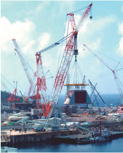
図4 大型クローラークレーンによる直接水切り
