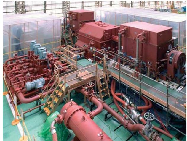
図7 中国電力株式会社島根原子力発電所3号機納めのRIP-MFGシステム
