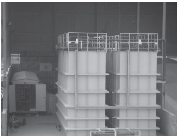
図7 水再生事業第1期プラントの外観
