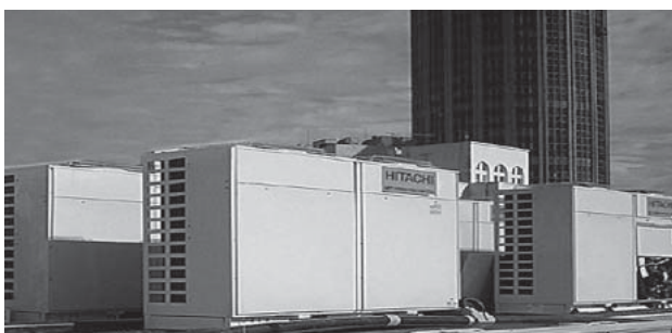
図6 セットフリー室外機の屋上設置例
