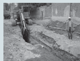
イエメン水道工事風景
