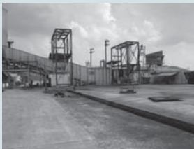
製糖工場の外観
