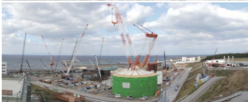
1 島根原子力発電所3号機の大型クローラクレーンでの原子炉圧力容器搬入状況（上）と大間原子力発電所の原子炉格納容器の地上組み立て状況（中央手前）（下）
