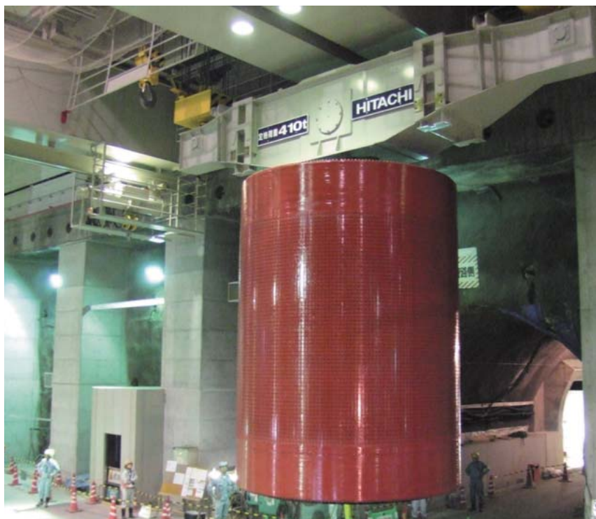
2 九州電力株式会社小丸川発電所4号機発電電動機回転子の据付け
