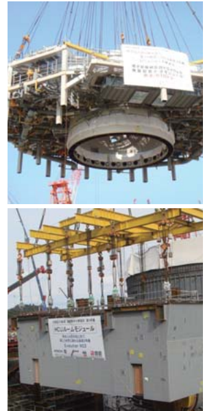
先行プラントにおける大型モジュールの導入例。
