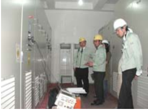
雲南省「省エネ見える化」の設置例(上)と、省エネインバータの設置場所(下)。
