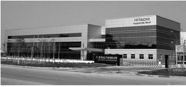
図9 | 南京日立産機有限公司の外観
