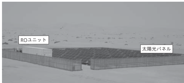
図5 | 太陽光発電利用淡水化システム
