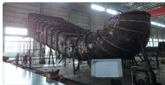
4 北海道企業局シュエパロ発電所 1号機水車下部吸出管
