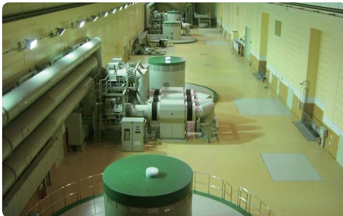
6 九州電力小丸川発電所全景
