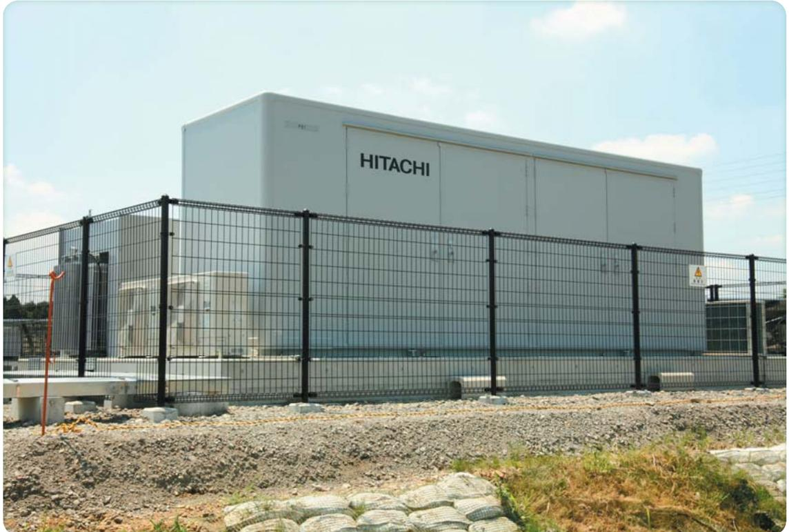
2 茨城県企業局水戸浄水場 1 MW太陽光発電設備(上)と、PCS2台を内蔵した屋外パッケージと昇圧変圧器で構成される中間変電所(下)
