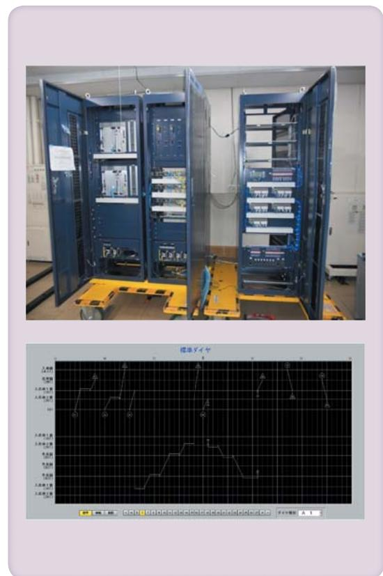
7 検車場運行管理装置（上）とダイヤスジ表示による画面例（下）
