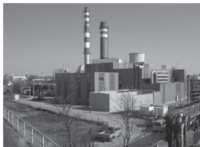
図9 | ハンガリーE.ON社ハンガリーNYKCEプロジェクト この発電所は系統に連系されており、付近にある工場に電源を供給するとともに、暖房熱源を供給するために建設された。
