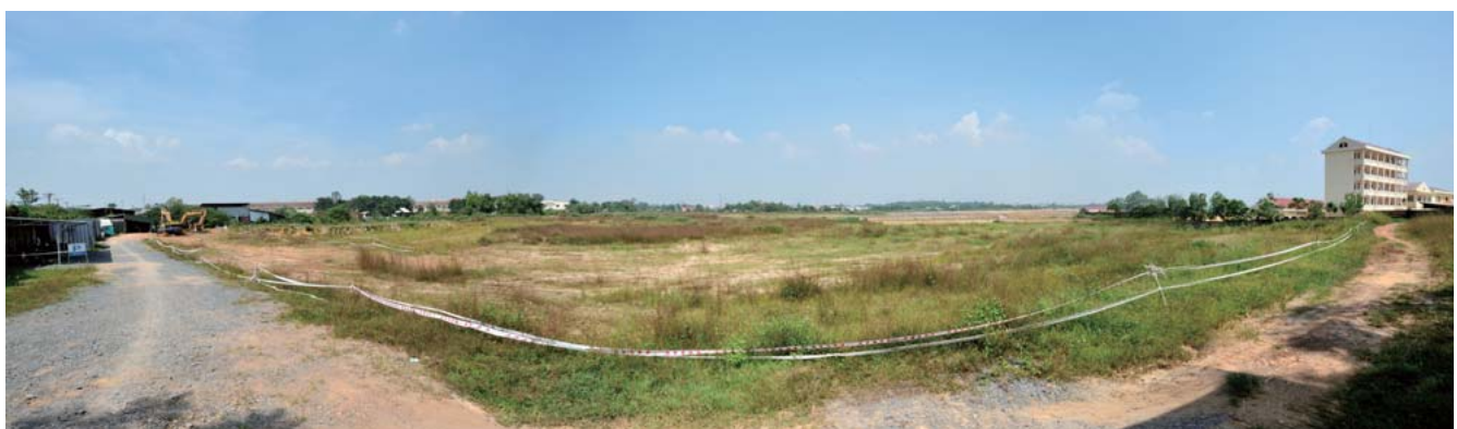
車両基地の建設予定地。日立は、基地設備のほかに5年間の保守事業も請け負う。
