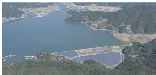
10 SGET芦北メガソーラー発電所
