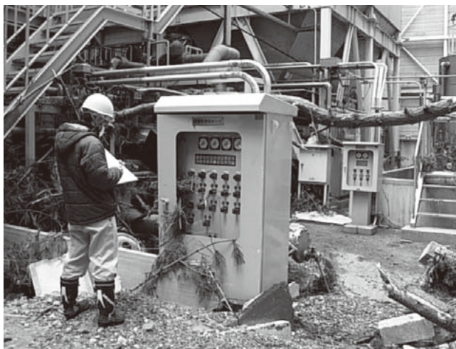
図2 被災調査状況
