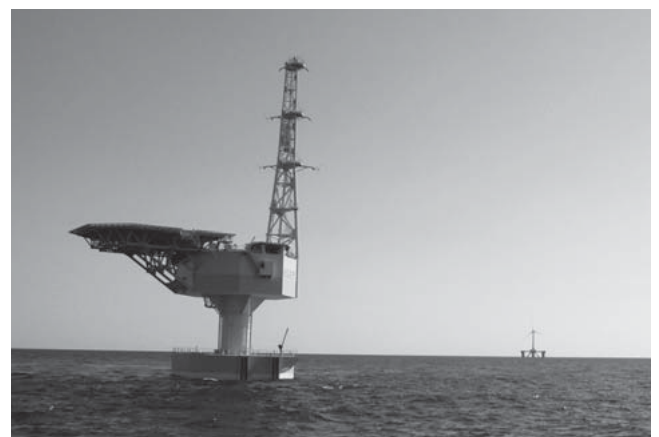
図9 | 洋上変電所外観
