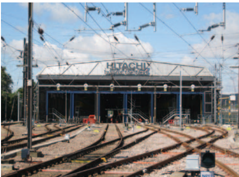
2015年3月に完成したノースポールデポ。IEPにおいては、このような車両保守基地をECMLとGWMLの沿線に全部で4か所建設する予定である。
