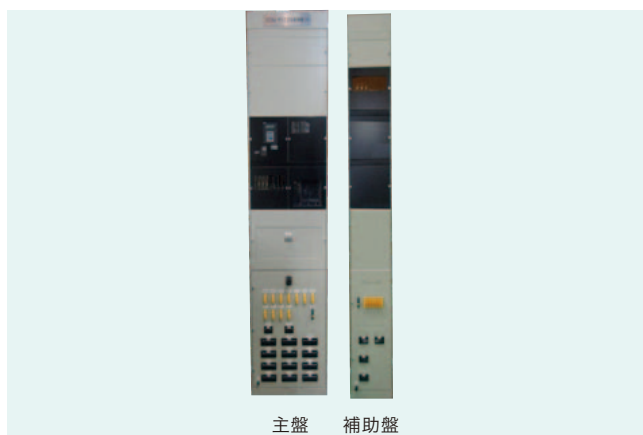
3 プロセスバス適用母線保護装置の外観
